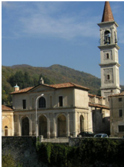
Campanile Chiesa di S. Stefano – Viggiù
